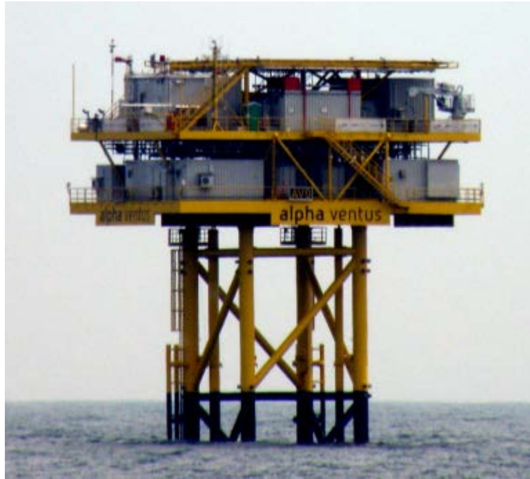
Stacja transformatorowa na farmie Alpha Ventus na Morzu Północnym w Niemczech
