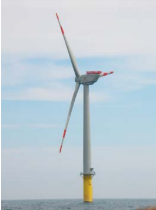
Morskie elektrownie wiatrowe na fundamencie monopalowym (po lewej) i kratownicowym (po prawej) – MFW Alpha Ventus na Morzu Północnym na niemieckich obszarach morskich
